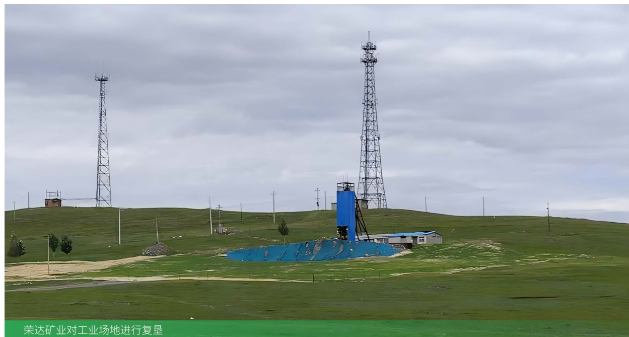
彝良驰宏对工业场地开展治理
